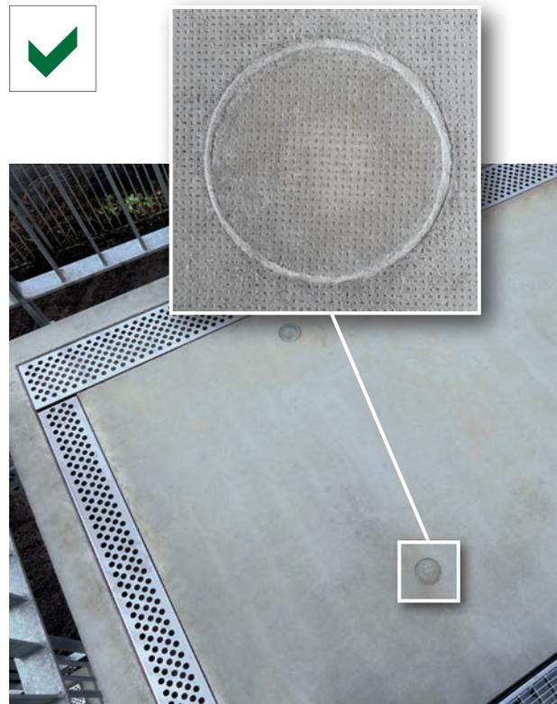
MARO<sup>®</sup>-Kegel verschließen Transportanker-Öffnungen **passend und effizient.**
